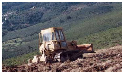
Bulldozer équipé de rippers - Forestiers-Sapeurs
